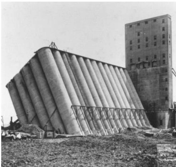
Рисунок 1. Падение Трансконского элеватора, Канада
